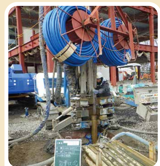
地中熱交換器設置状況
